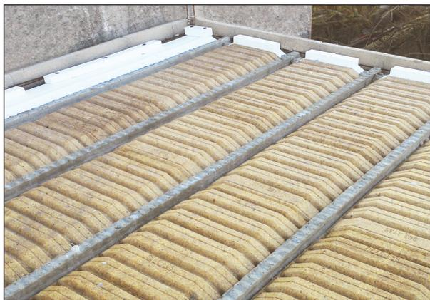
En transversal : plancher EBS et Rupteur Stoptherm EBT. La mise en œuvre est simplifiée grâce au jeu de pose de l'EBS et à sa sécabilité tous les 10 cm.
