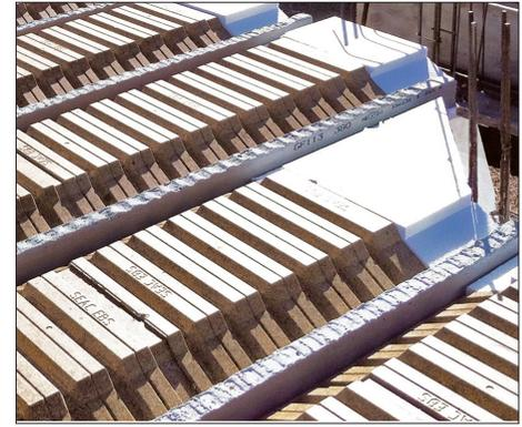
Rupture thermique en zone biaisée avec le Stoptherm ES (Seacbois)
