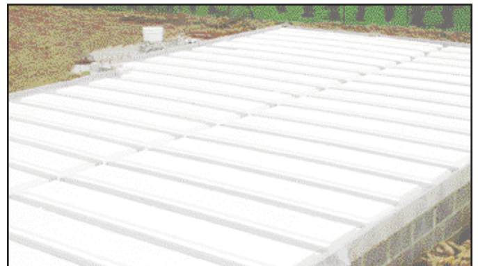
Plancher vide sanitaire à entrevous Polyseac
