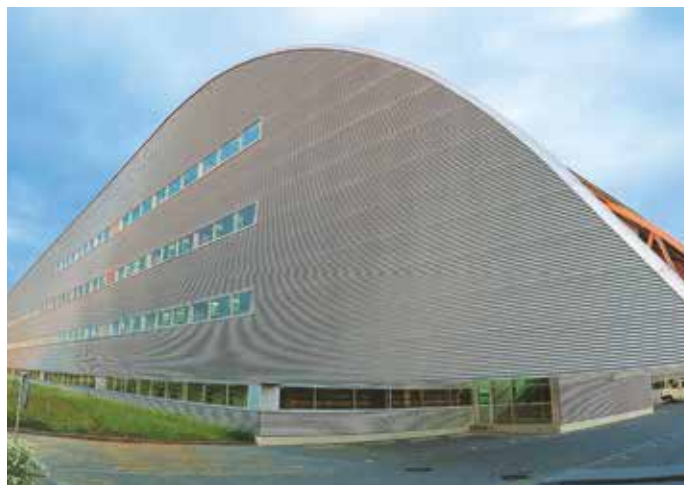
Bâtiment commercial Würth, Den Bosch (NL) Architecte: De Twee Snoeken
