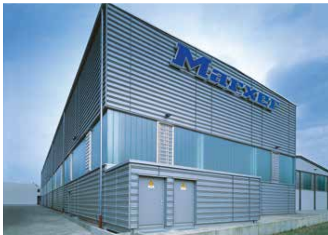
Hall industriel Marxer, Friedberg (D) Architecte: Bureau d'architecture Dieter W. Hoppstaedter
