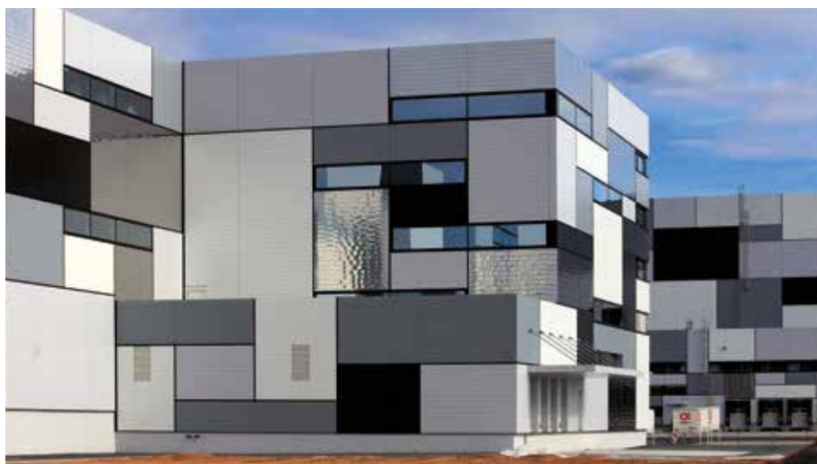
Gries Deco Company GmbH, Niedernberg (D) Architekt: netzwerkarchitekten, Darmstadt
