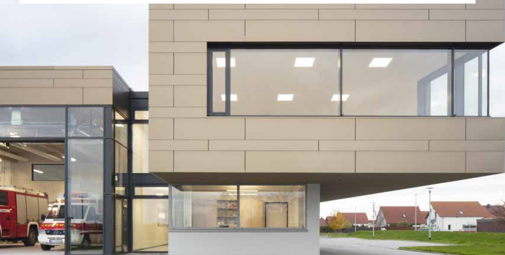
Caserne de pompiers Sickinge (GER) Architecte: struhkarchitekten BDA Planungsgesellschaft mbH
