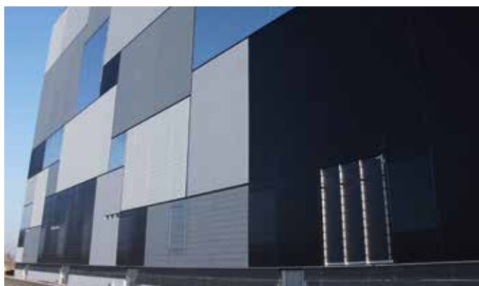
Montage des panneaux Kalzip FC indépendamment de la direction.
