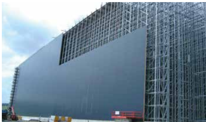
Montage rapide et rentable des éléments sandwich FischerTHERM avec joint DUO.
